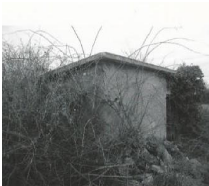
Le transformateur abandonné après la guerre
