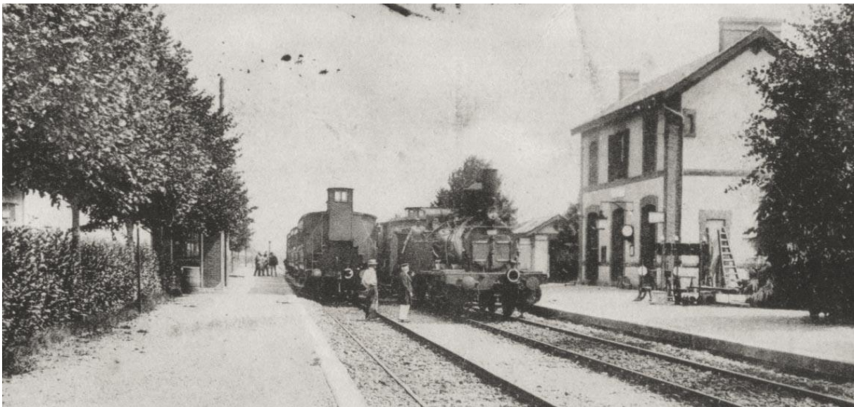
Croisement de trains en gare de Treillières
