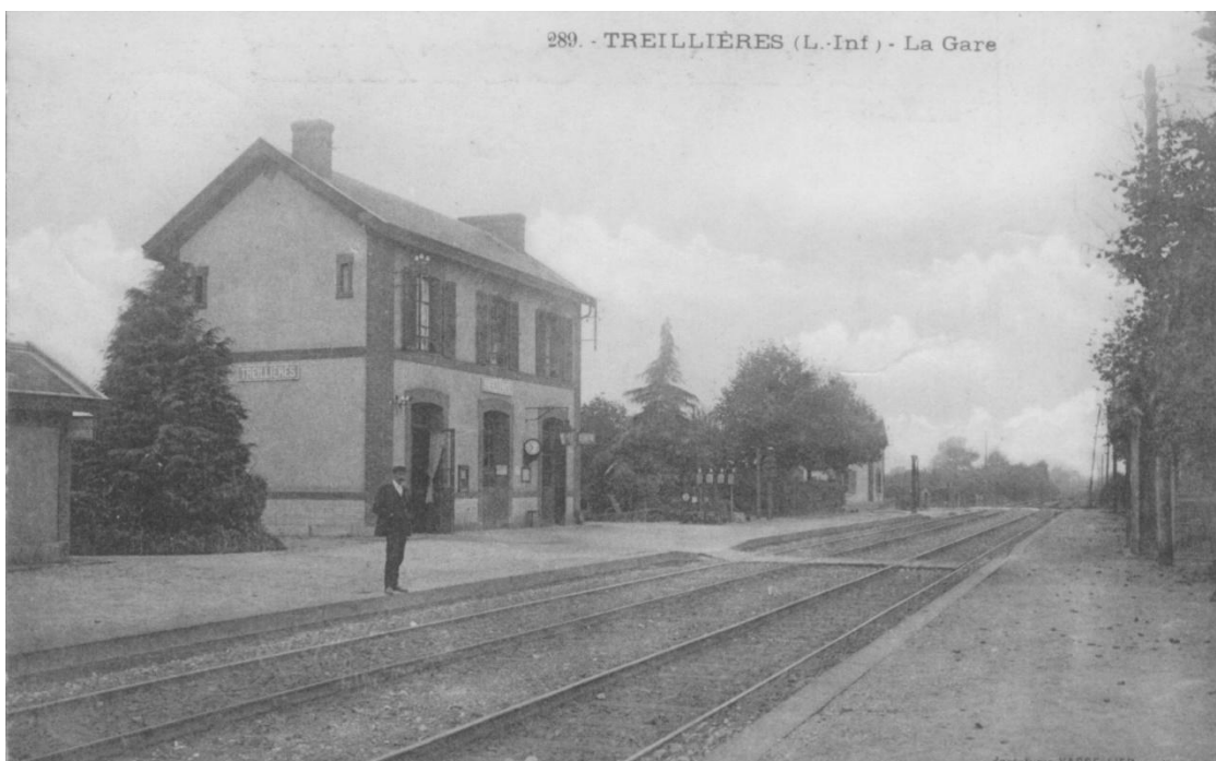
La gare ; au bout du quai à gauche on aperçoit la maisonnette du garde barrière du passage à niveau (PN 35)
