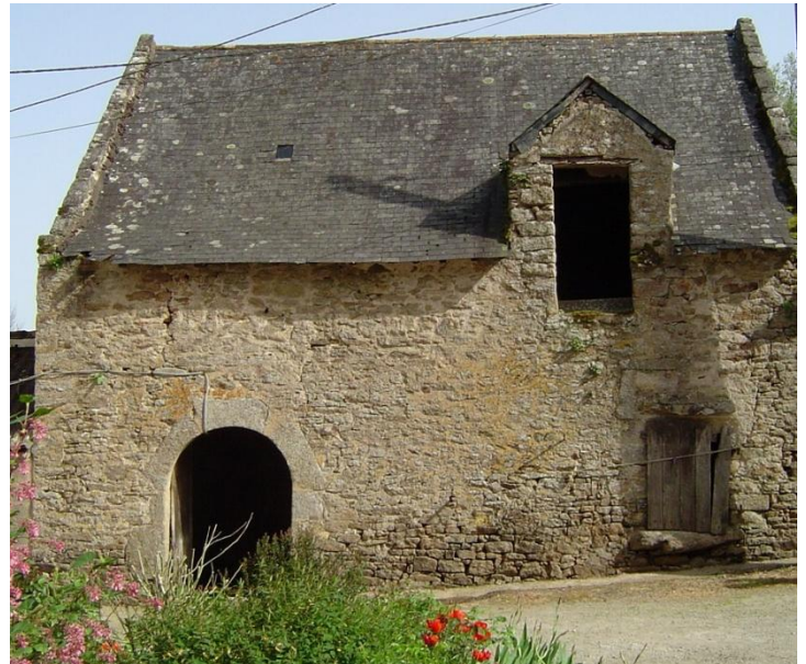
Dans les métairies, déjà avant le 19 e siècle, l'étable est séparée de la maison d'habitation (Etable de la métairie de La Louinière – photo 2011)
