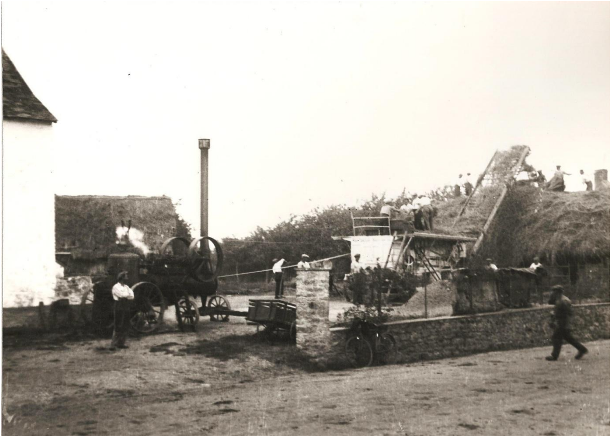
Battages chez Jean Jarnet dans les années 1930 : les hommes s'affairent sur la batteuse entraînée, à l'aide de courroies, par une machine à vapeur
