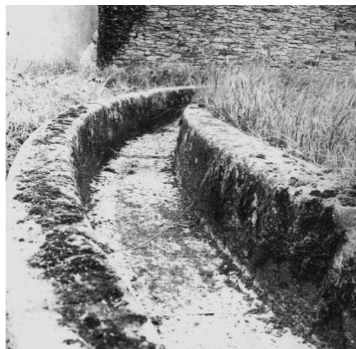
**Le pilage de Gesvres en 1985 : on y écrasait les pommes, avant de les mettre dans le pressoir, au moyen d'une roue en pierre actionnée par des bœufs.**
